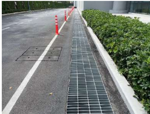
รูปที่ 47 ตะแกรงปิดรางระบายน้ำ
